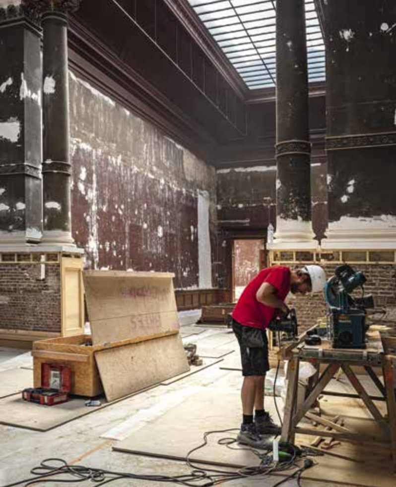
Werkzaamheden aan de lambrisering in de oude zalen B en D in 2019
